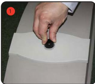
1 Dévisser les 4 vis des embases et mettre les de côté
